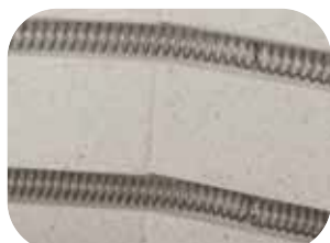
Varmelegemer, monteret beskyttet i riller
