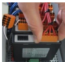
Fig. 11: Montere styringsmoduler (illustrasjon – kan avvike fra faktiske forhold)
